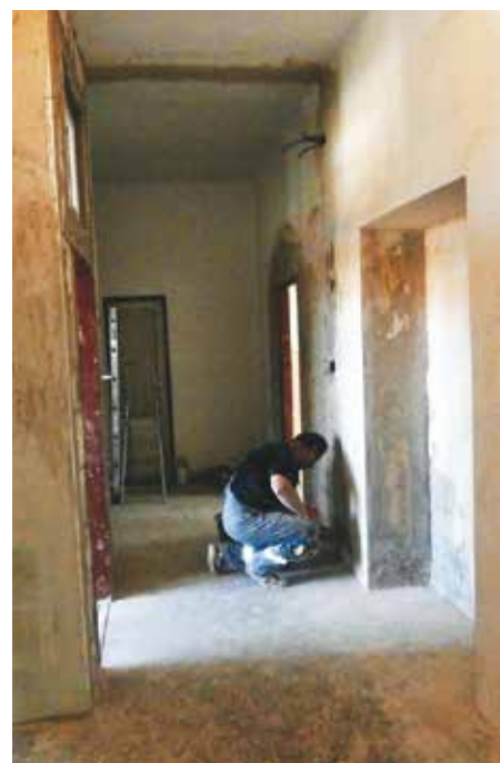
Z prerábania učební a kabinetov ZŠ na poschodí na MŠ pre 28 detí
