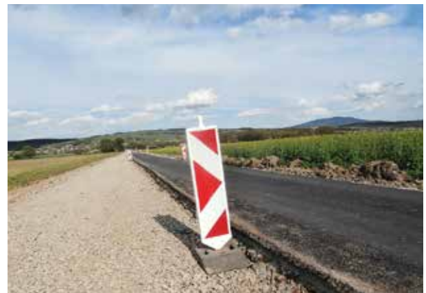
Práce na rekonštrukcii cesty trvali od apríla do konca mája
